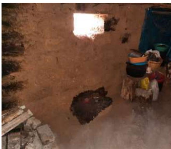
El ambiente de la cocina está construido con adobe y techo de calamina, con poca iluminación. La cocina ubicada en una esquina del ambiente, es un fogón adaptado con adobe y varillas de hierro para dar soporte a las ollas, no tiene chimenea y como consecuencia de ello, se tiene las paredes ennegrecidas por el hollín.
