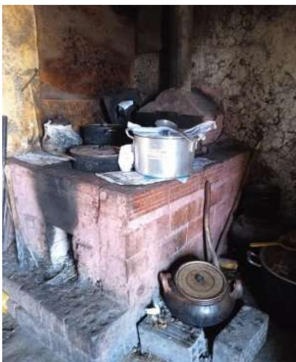
En el interior de la cocina existe una cocina mejorada con chimenea (ducto de ventilación vertical hacia el exterior) en regular estado de conservación, se aprecia muro y ollas ennegrecidas por humo, lo cual es señal de su funcionamiento inadecuado. Así mismo, hay una olla casi nueva. Al costado hay un fogón elaborado por piedras, olla ennegrecida y leña.
