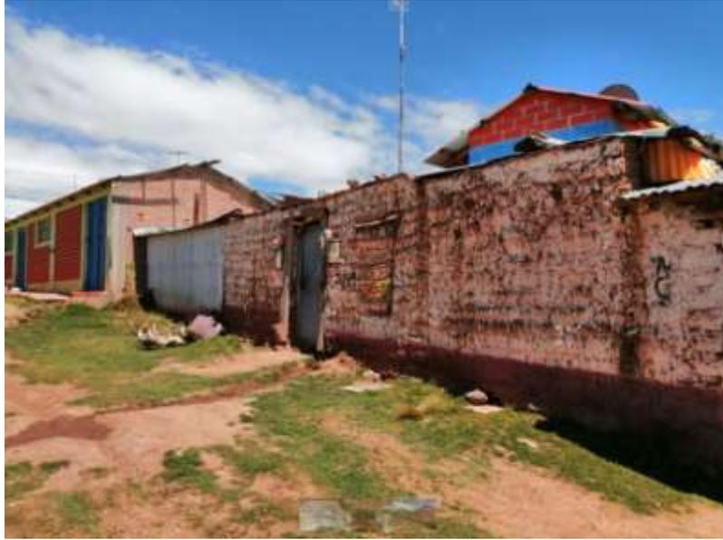
Vista de la parte frontal de la vivienda que consiste en un muro de adobe y cubiertas de los vanos con calaminas metálicas y mantas
