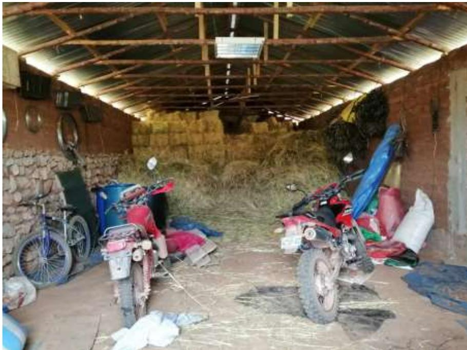
Módulo construido con base de piedra de aprox. 1.50m y ladrillos de adobe que sostienen la estructura de madera del techo en dos aguas y recubierto en calaminas metálicas.
