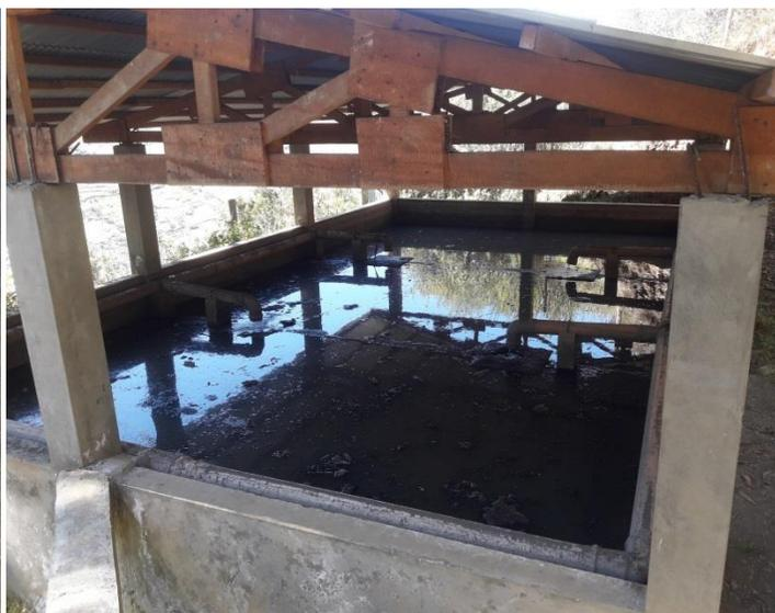
Las pozas de filtración de residuos no se encuentran funcionando bien y constantemente los conductos de filtración de la poza requieren la limpieza de desechos.
